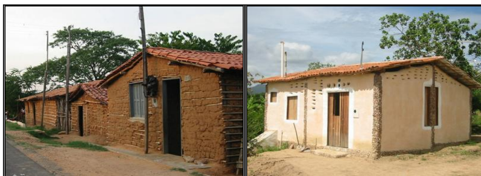
Figura 19: Casa de taipa sem reboco e com rachaduras. E casa de taipa com reboco. Fonte: Disponível em: http://www.verdesaine.net/arquitetura_ecologica . Acesso em: 22 de novembro de 2011.
