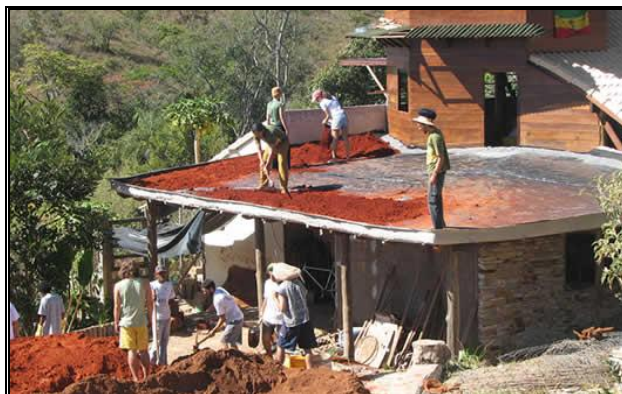
Figura 8: Sítio Tamanduá. Construção da casa principal. Fonte: http://sites.google.com/site/sitiotamanduá/
