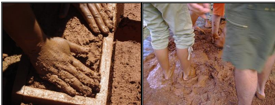
Figura 16: Biocontruindo tijolos de adobe. Fonte: Disponível em: < http://planetasustentavel.abril.com.br/blog/gaiatos-e-gaianos/87312/ > e < http://pedaleco.blogspot.com/2007_02_01_archive.html >. Acesso em 22 de novembro de 2011.
